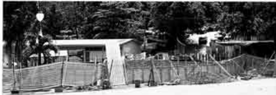
El nuevo escenario en la plaza de Castañer bajo construcción.
